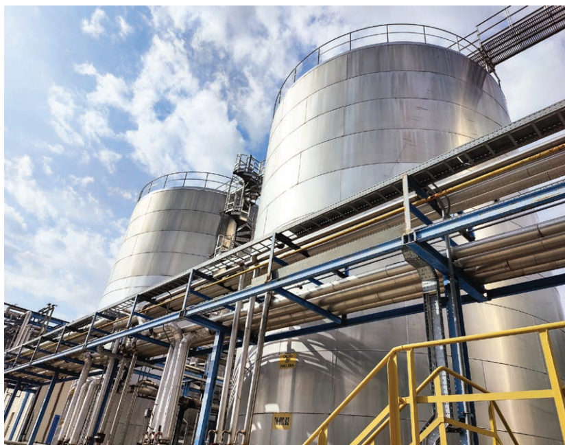
Usine de biodiesel
